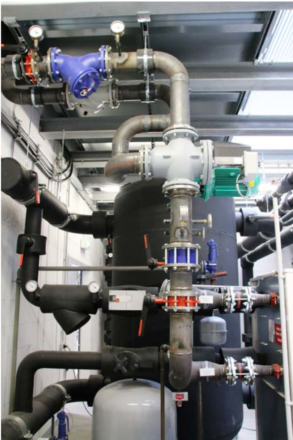
Kälterohrleitung
