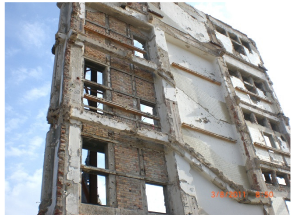
Ansicht „Bestandsfassade“ während der Bauphase
