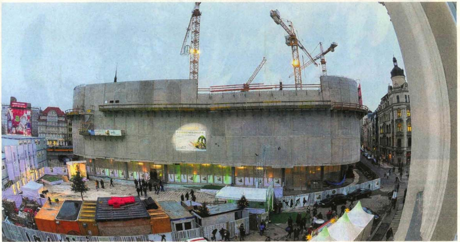
Der Rohbau der Blechbüchse ist – mit Ausnahme des zurückgesetzten Staffelgeschosses ganz oben – fertig. Im Frühjahr kommt die historische Alu-Hülle dran. Fotos: Andreas Döring
