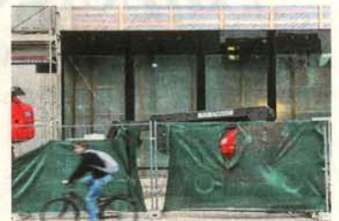
Am Brühl (nahe Hallisches Tor) ist schon das erste Stück der Glasfassade montiert.
