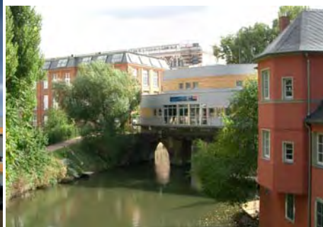
Ansicht mit Karl-Heine-Kanal
