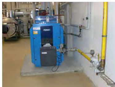
Heizzentrale, Gas-Heizkessel
