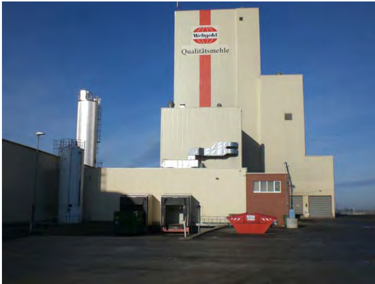
Ansicht Mühle mit Produktions- und Lagerhalle
