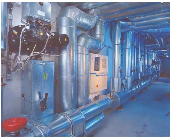
Verteiler Kältezentrale
