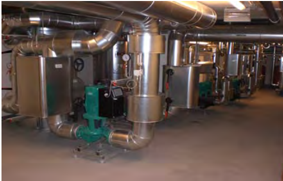
Blick auf Lüftungszentrale Dach Bürogebäude CR 16
