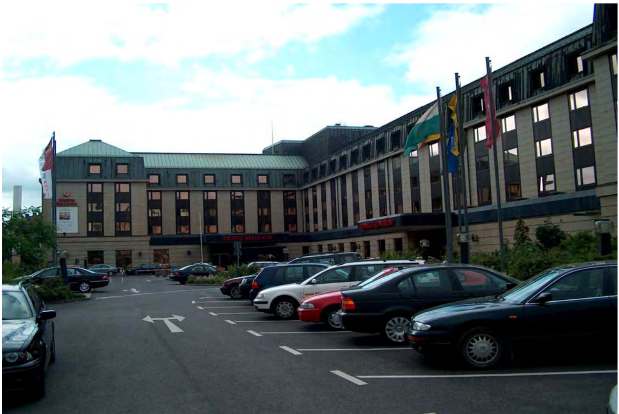
vordere Ansicht / Eingang
