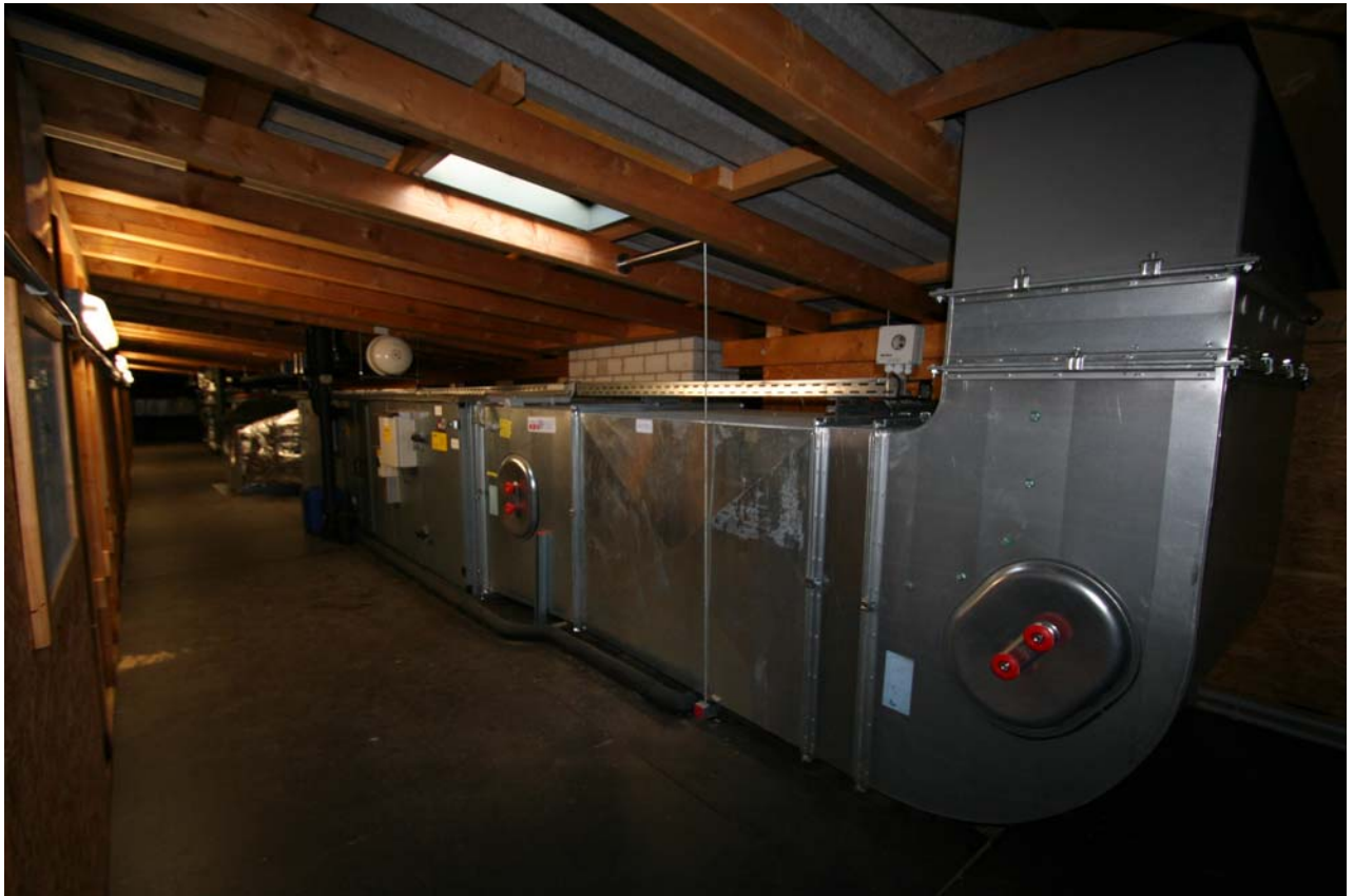
Abluftanlage unter Satteldach
