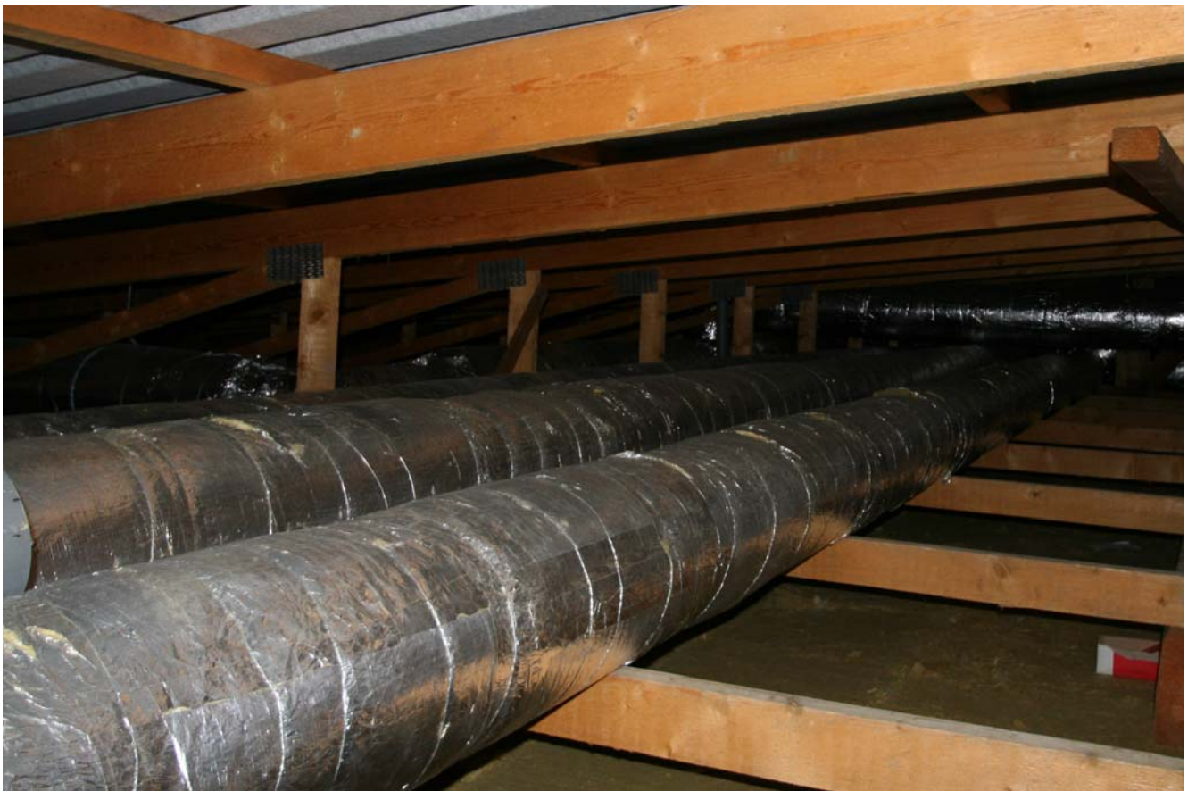
Isolierte Lüftungsrohe im Spitzdachbereich
