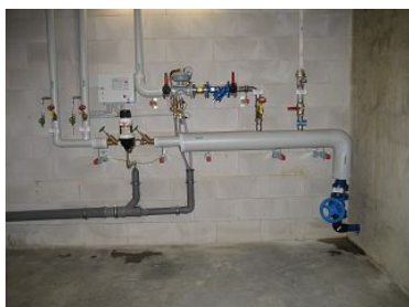
Trinkwasserverteiler
