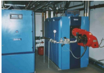
Heizzentrale BHKW und Kessel
